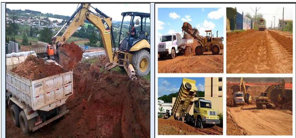
Figura 92. Exemplos de amostragem do Depósito tecnogênico do tipo espólico e uso na terraplanagem.
