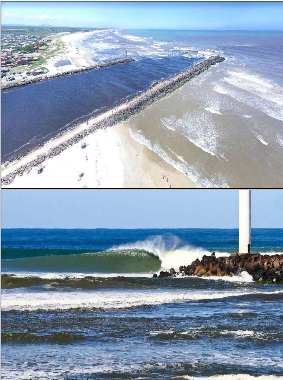
Figura 117. Imagens que mostram os molhes do rio Mampituba, na divisa dos municípios de Torres (RS) e Passo de Torres (SC). Os molhes representam o Depósito tecnogênico espóico, a base de fragmentos rochosos (basaltos) e sedimentos heterogêneos do ponto de vista textural. A imagem inferior exhibe os molhes em território catarinense (Fonte: www.temporadalivre.com ; www.cidadesdomeubrasil.com.br ).
