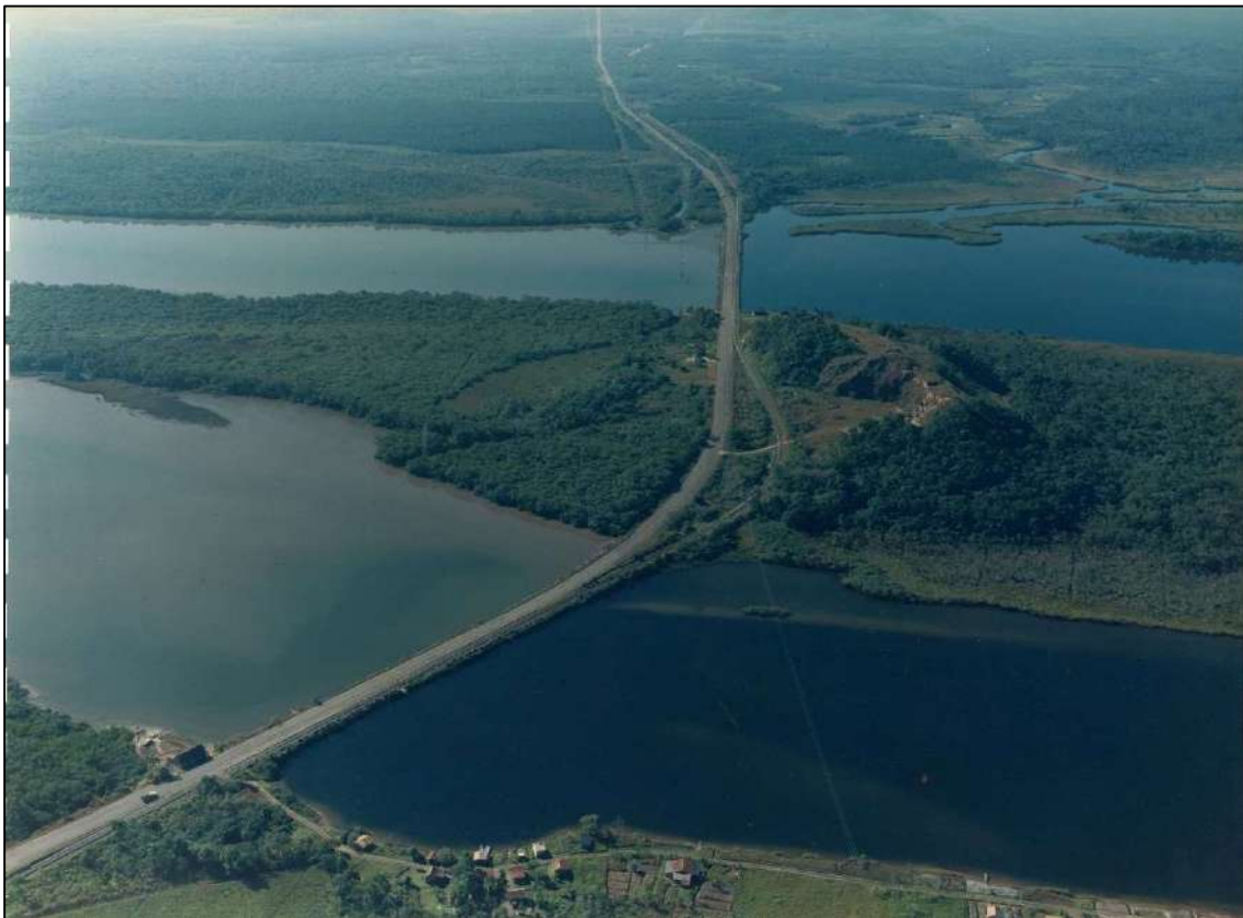
Figura 60. Vista para nordeste dos aterros da BR 280 no canal do Linguado, no limite territorial entre os municípios de Araquari e São Francisco do Sul, construídos a partir do Depósito tecnogênico espóico explotado da ilha do Linguado e áreas circunjacentes (Fonte: HORN FILHO, 1997).
