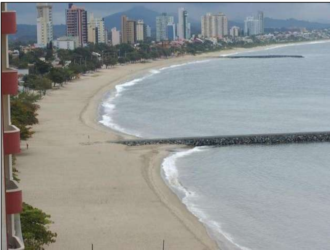
Figura 67. Vista para norte do Depósito marinho praiado do Holoceno junto à linha de costa da praia de Piçarras no município de Balneário Piçarras, observando-se a orla urbanizada com dois molhes de contenção devido à erosão costeira, construído com fragmentos do Depósito tecnogênico espólico (www.skysrapercity.com).
