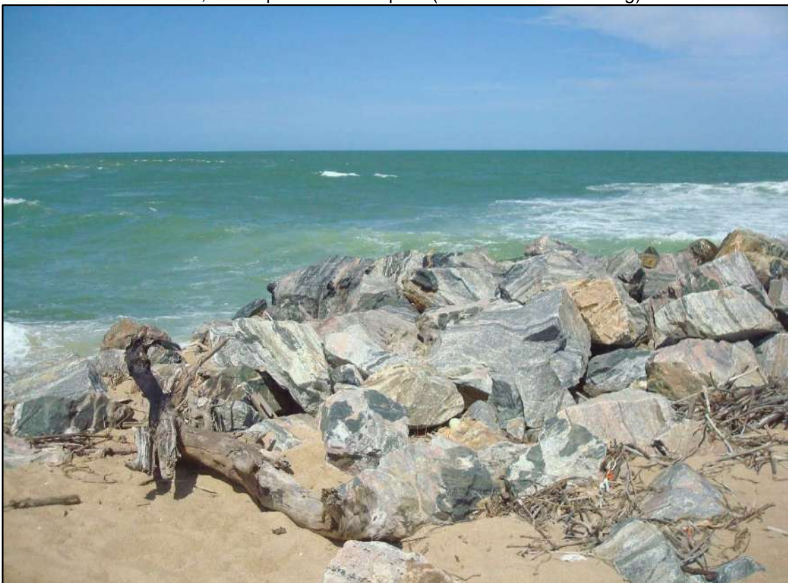
Foto 44. Utilização do rochas do embasamento para recomposição e proteção da praia de Barra Velha, município de Barra Velha (Foto de Norberto Olmiro Horn Filho, dezembro de 2019).
