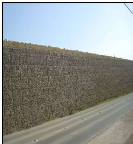
Foto 24. Vista do Depósito tecnogênico do Holoceno às margens da rodovia BR 101, no município de Maracajá, na forma de um aterro contido por muro de gabião, constituído de diabásios explorados de uma jazida a céu aberto do embasamento indiferenciado. Fonte: Foto de Norberto Olmiro Horn Filho, nas coordenadas geográficas 28°56'26,1"S. e 49°21'29,3"W.
