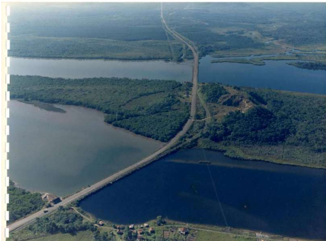
Figura 150. Vista para nordeste da ilha do Linguado, uma típica ilha fluvial junto ao canal do Linguado, municípios de Araquari e São Francisco do Sul, cujas rochas foram explotadas para implantação dos aterros (Depósito tecnogênico) que representam o único acesso rodoviário à ilha de São Francisco do Sul (Fonte: HORN FILHO, 1997).
