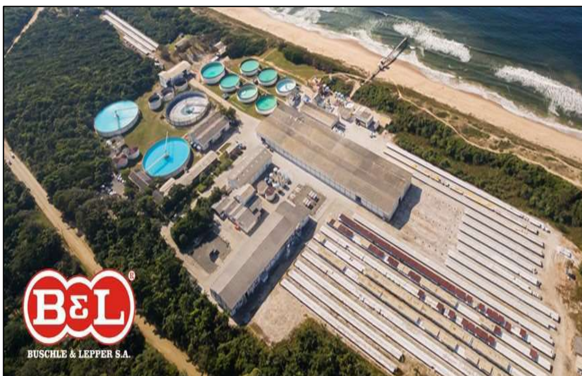
Figura 62. Visão geral da infraestrutura da Unidade de Magnésio e Derivados da Buschle & Lepper S/A , instalada na planície costeira do Balneário Barra do Sul, onde são produzidos derivados de magnésio, extraídos da água do mar e hidróxido de alumínio.
